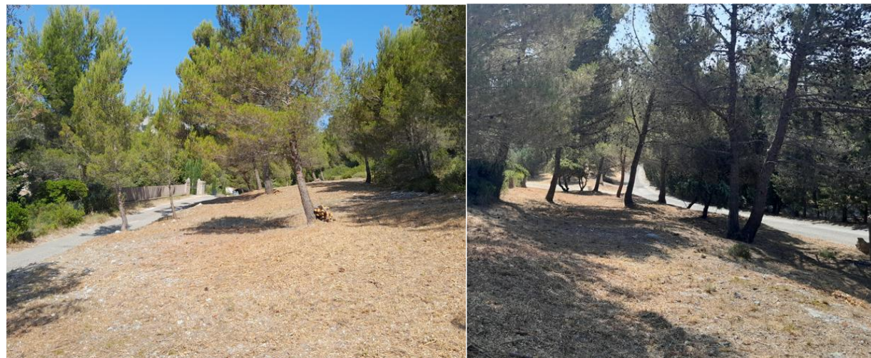
chemin de Baubesse : débroussaillage, élagage, marquage des arbres à abattre
