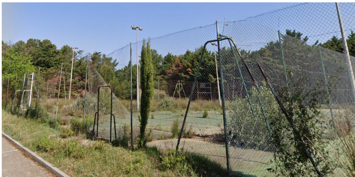
Courts de tennis du Country Club des Baux-de-Provence
