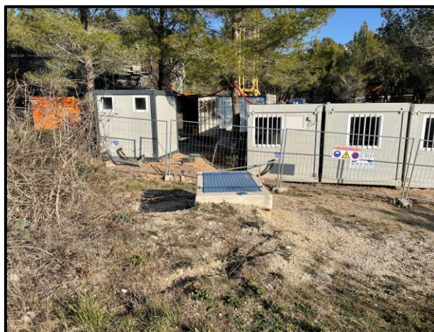
Figure 6 : Vue extérieure d'un des forages des Arcoules
