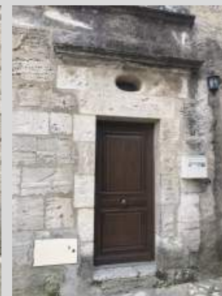
Linteau droit en pierre
