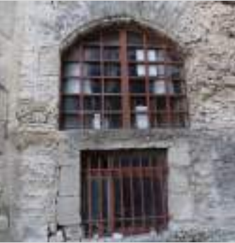
Menuiserie non conforme au style architectural (invention), possibilité de créer un vitrage plein dans une écriture contemporaine
