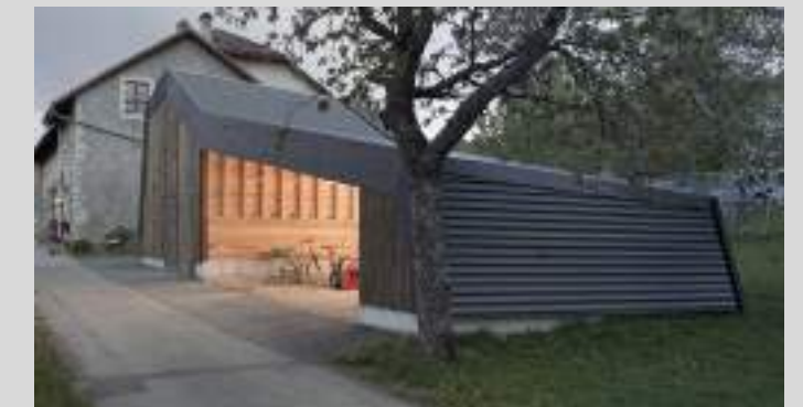
Exemple hangars agricoles en Suisse.
