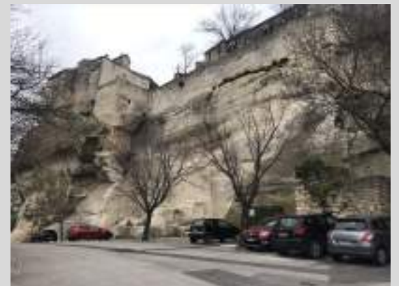
Les arbres du parc de stationnement offrent un couvert protégeant les voitures du soleil et un toit végétal au stationnement qui ainsi n'est pas perçu de façon dominante depuis le village.
