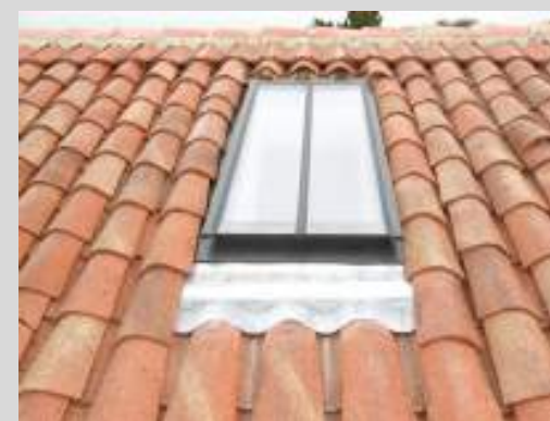
Châssis de toiture intégré à la couverture sans aucun élément saillant de type volet roulant solaire
