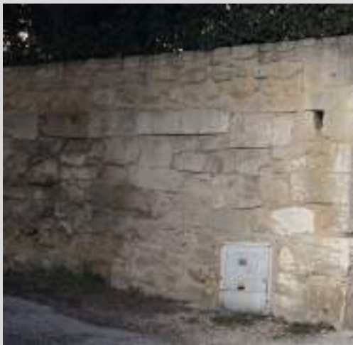
Le couronnement ne présente pas une régularité parfaite ce qui répond mieux aux murs de pierres sèches.
