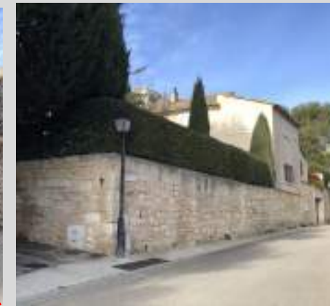
Une bande différenciée sera mise en œuvre en pied de mur. Le revêtement ne devra pas recouvrir le pied de mur pour le laisser respirer.
