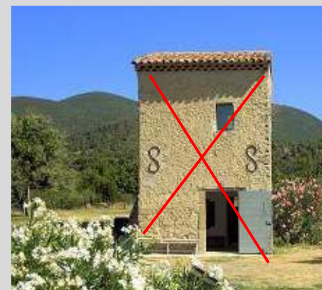
Exemple de surélévation inadaptée (Luberon): la hauteur est trop importante par rapport à l'assise: perte du volume initial du cabanon.
