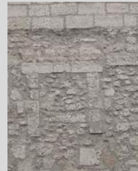
Percement bouché pouvant être réouvert. Dans le cadre de travaux la mise en œuvre d'un enduit sur les pans de murs est obligatoire.
