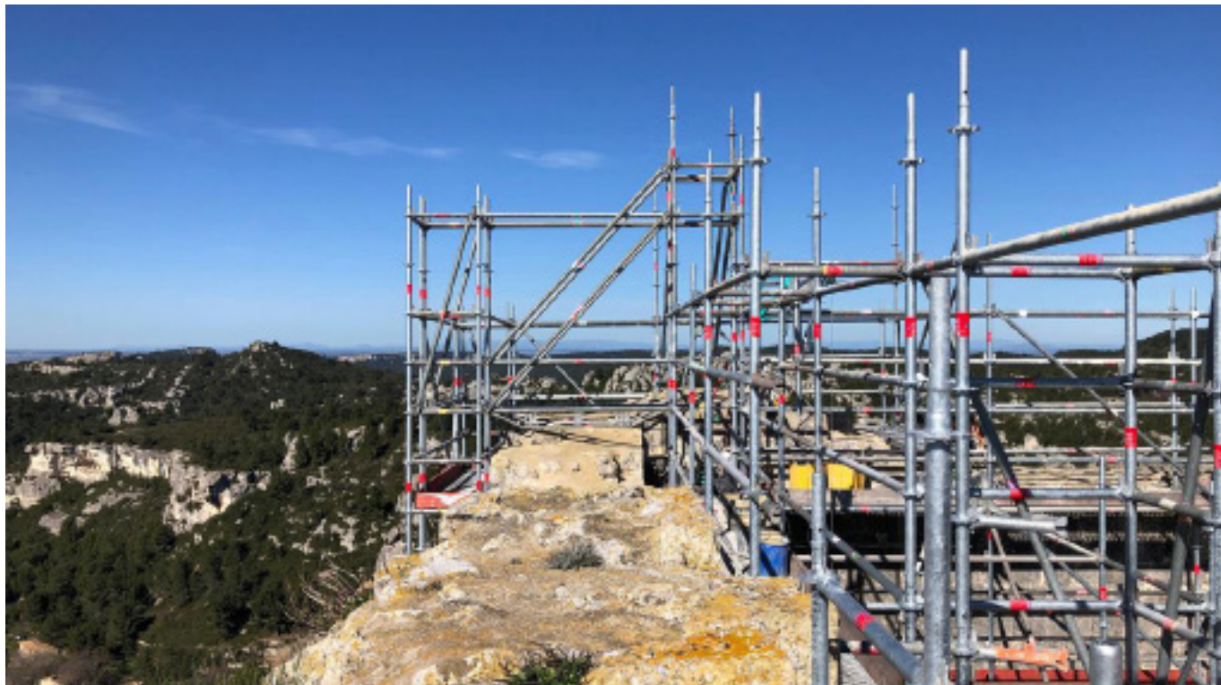
Le chantier du donjon a nécessité l'intervention d'un hélicoptère. Les pierres, trop grandes et trop lourdes, ont dû être acheminées sur site par voie aérienne.
