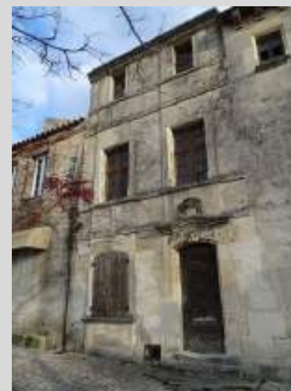
Façade ordonnancée : les percements ne sont pas appelés à évoluer
