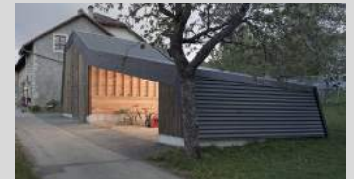
Exemple hangars agricoles en Suisse.
