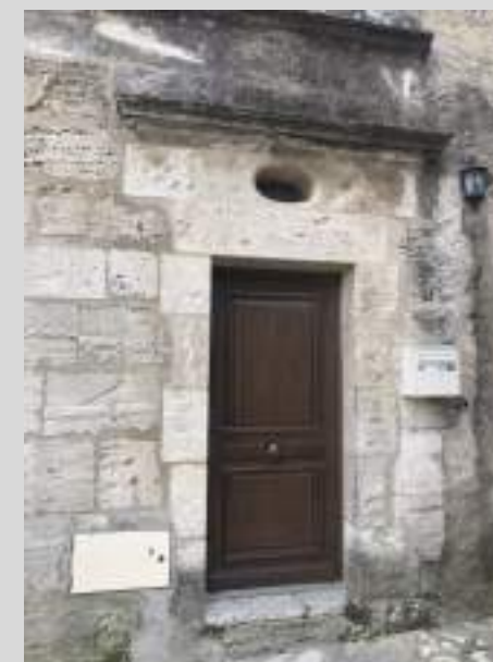
Linteau droit en pierre
