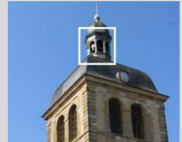
Exemple, Vézelay, intégration de l'antenne relai dans le clocher de l'église Saint Pierre
