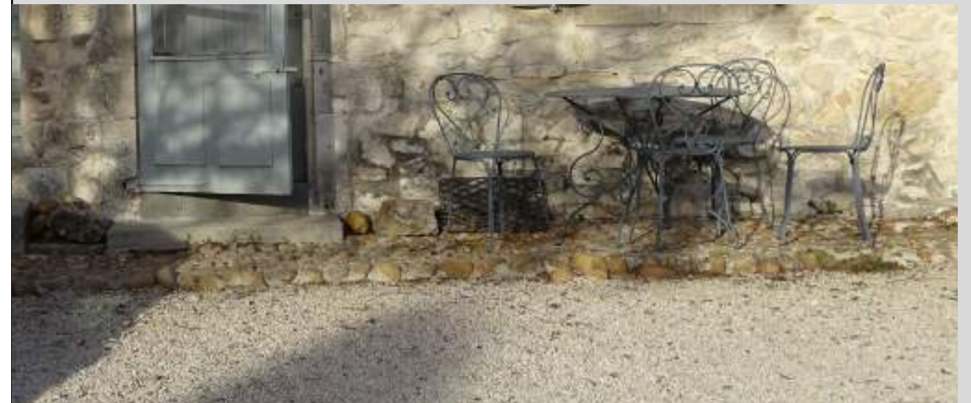
Exemple de traitement autour d'une maison : calade et gravillons
