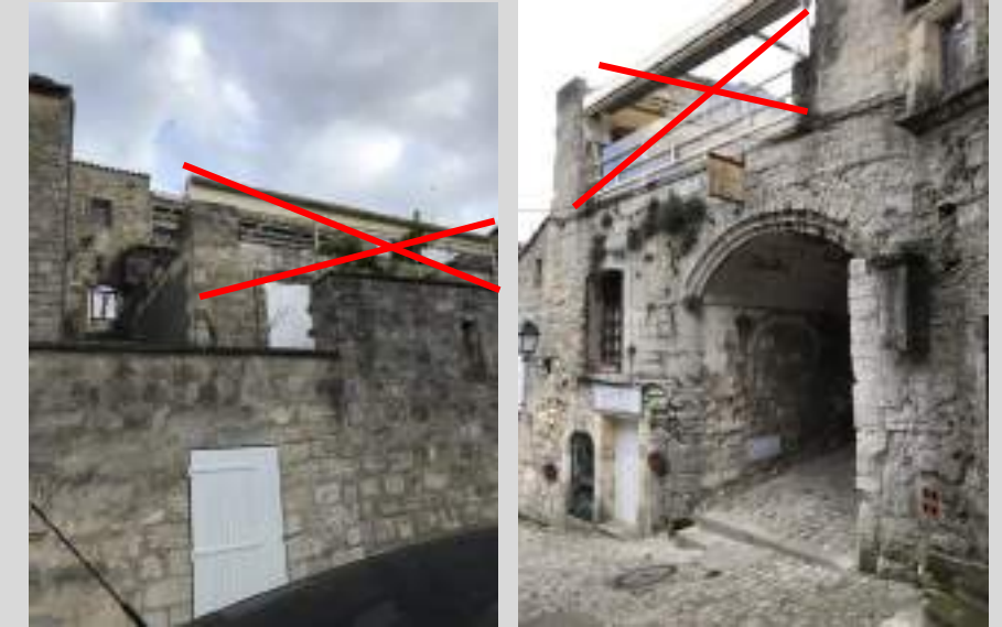
Dispositifs insuffisamment intégrés
