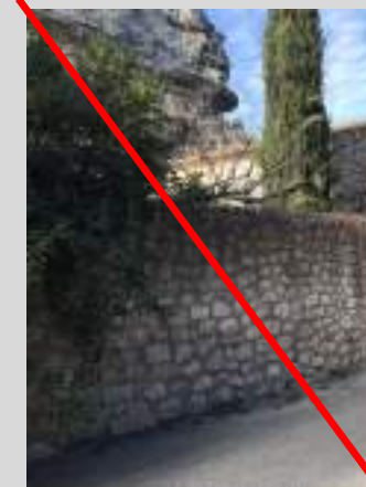
Une bande différenciée sera mise en œuvre en pied de mur. Le revêtement ne devra pas recouvrir le pied de mur pour le laisser respirer.
