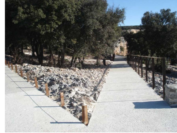
Accompagner les cheminements : traitement de sol en béton sablé
