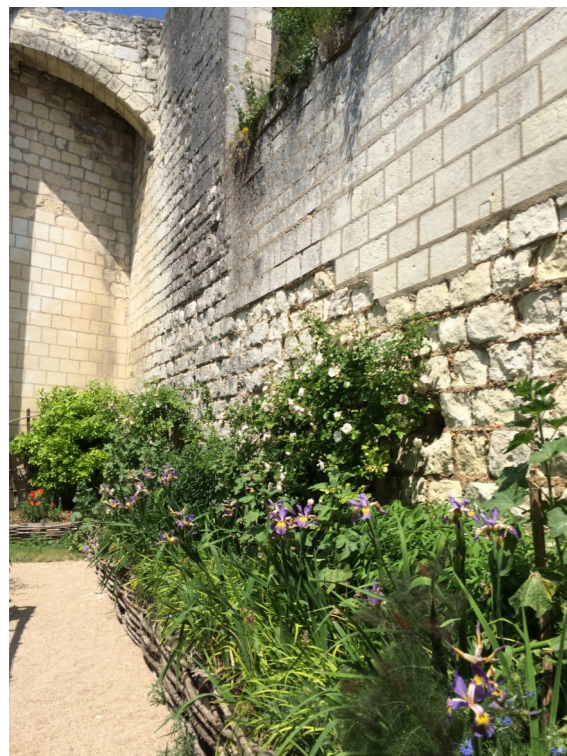
Loches : végétalisation sur les parcelles et en pied de mur
