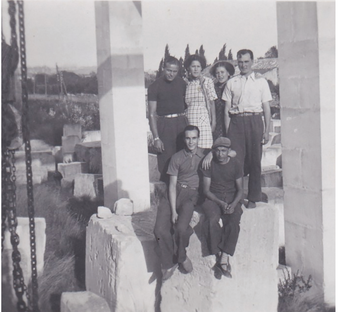
Pont roulant au Nord de la gare Les Baux - Paradou qui permettait le déchargement des blocs extraits des carrières baussenques de Sarragan et des Grands Fonds dans le Val d'Enfer.
